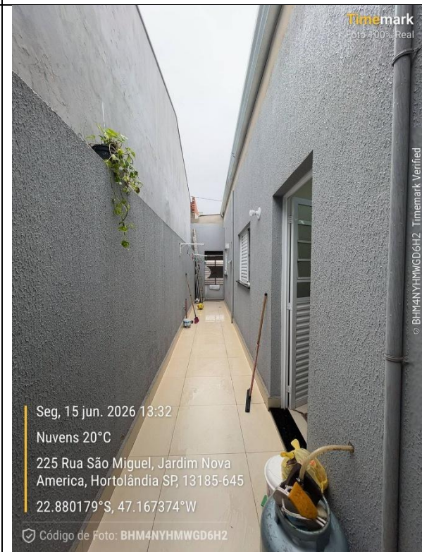
FOTO 20 – Corredor Lateral de Acesso da Área de Serviço para Garagem
